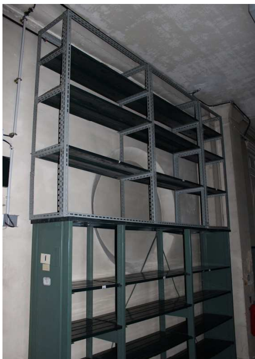
Dépôt Louis-Philippe, 2 e étage, salle 209 : rayonnages sans protection devant un oculus
