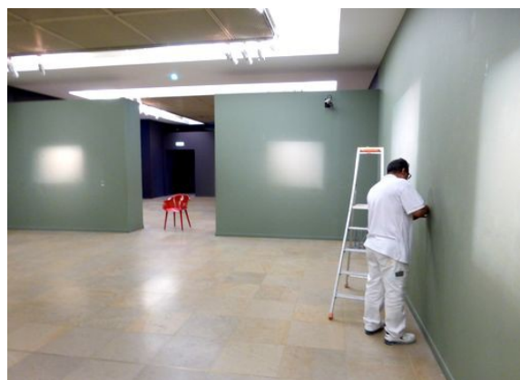
Salles des collections permanentes RC en réfection, enduit, rebouchage, peinture
