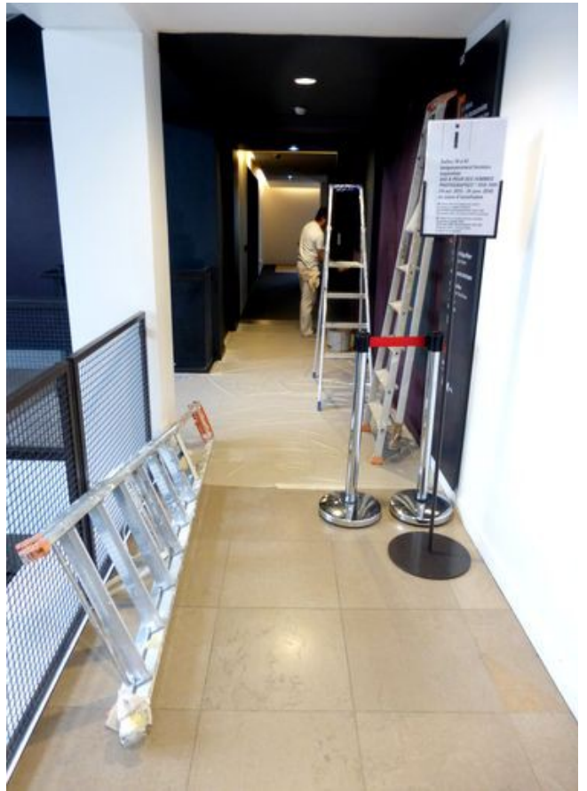
Travaux palier escalator public
