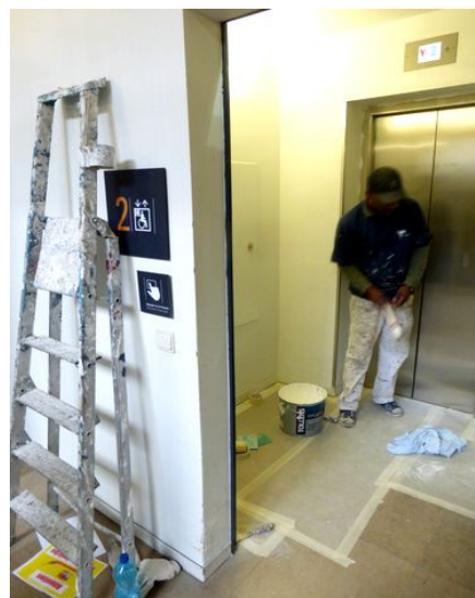
Autre ascenseur public, en travaux
