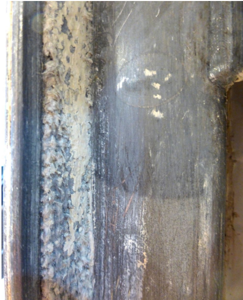
Tresses d'amiante collées passées au décapant
